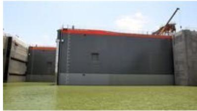
Una esclusa es una estructura hidráulica que permite hacer un canal navegable y permite a los barcos cruzar a desnivel. La esclusa incluye una bolsa de aire en el que es posible variar el nivel del agua y está delimitado por las puertas. Las esclusas del canal de Panamá tienen por objetivo el mantenimiento de estanques diseñados sin la interrupción del tráfico. En cada esclusa, el reciclaje se realiza por un sistema de llenado y vaciado por gravedad:
